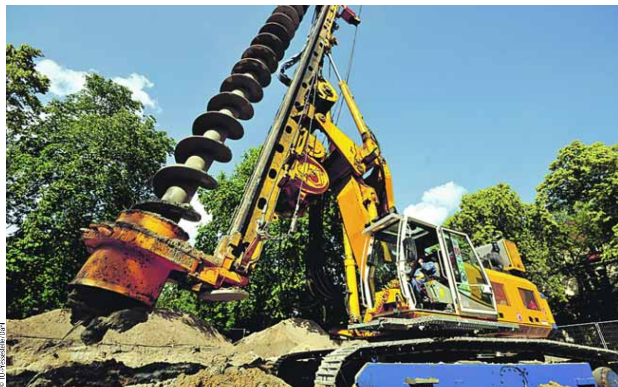
Rund 120 Bohrungen, die bis zu zehn Metern in die Tiefe reichen, werden für das Fundament des Gebäudes auf dem Nordcampus vorgenommen
