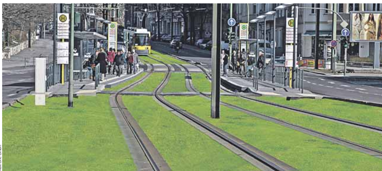
Beispiel eines Rasengleises in Berlin
