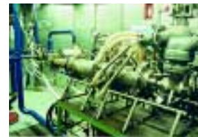
Prüflauf eines Turboladers
